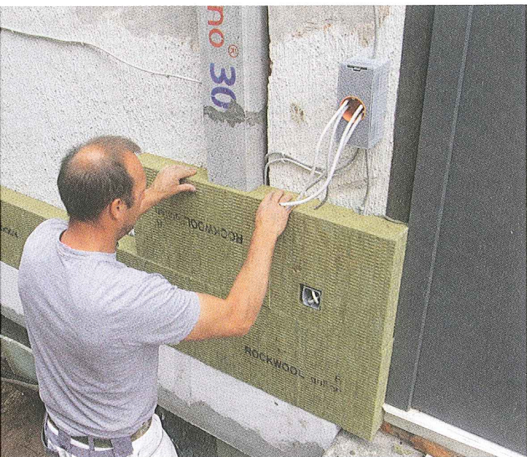
Mit dem Tiefenmaß 13 cm beim SKOBIFIXnano bzw. 15 cm beim SKOBIFIXXs lässt sich die Abgasanlage komplett in der Wärmedämmung verstecken.
